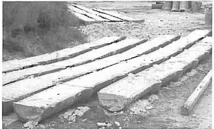
Færdigstøbte overkanaler med cellebeton
