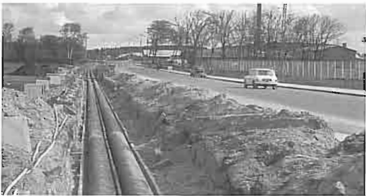
Ledningsarbejde på Kejlstrupvej
