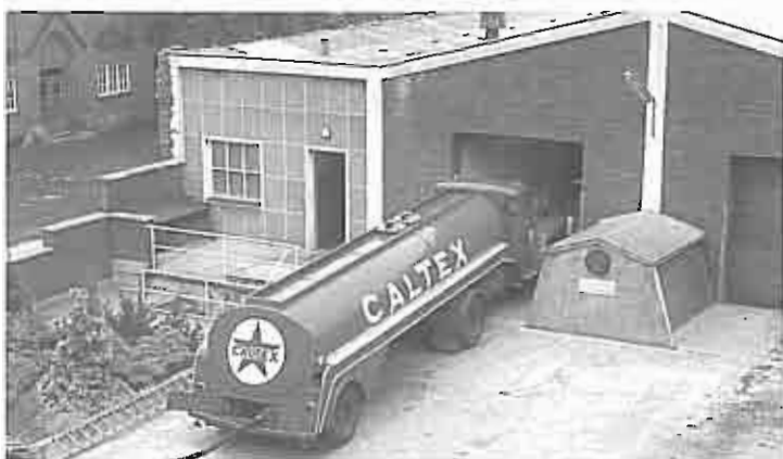
Levering af ca.80 grader varmt tungt fyringsolie
