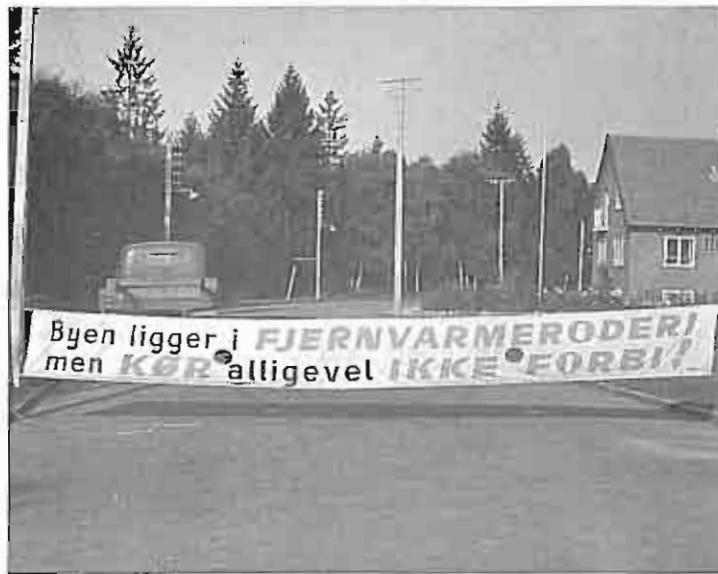
Oplysning om fjernvarmearbejder i Silkeborg
