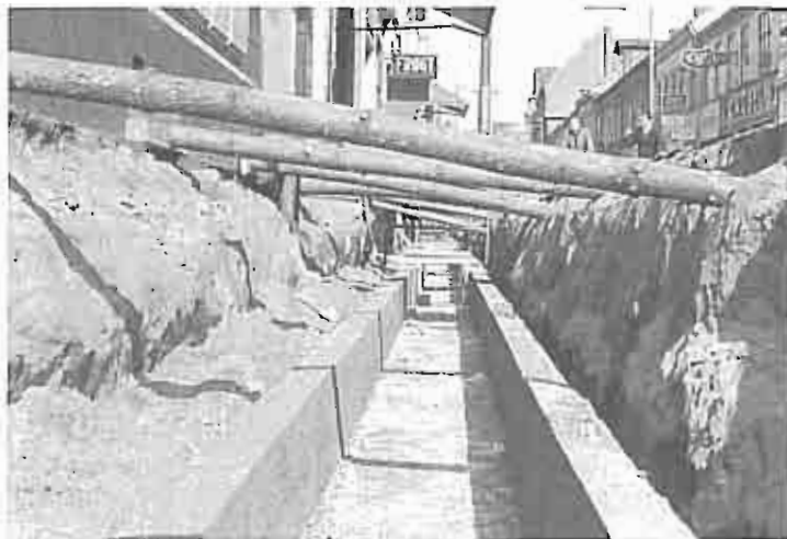
Fjernvarmekanaler støbt på stedet
