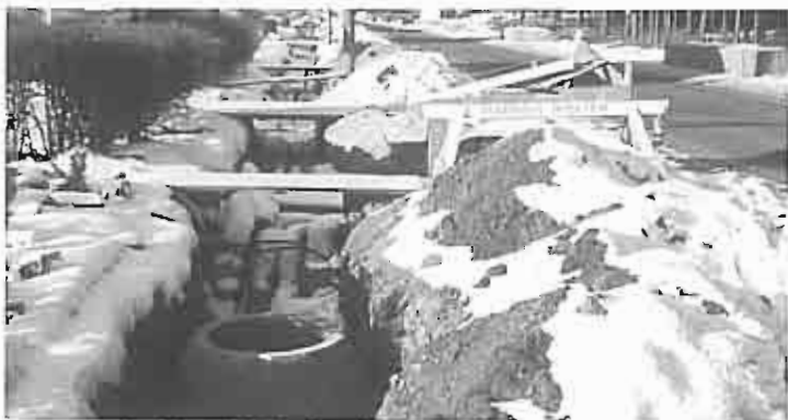
Ledningsarbejde på Nylandsvej 1968 / 69
