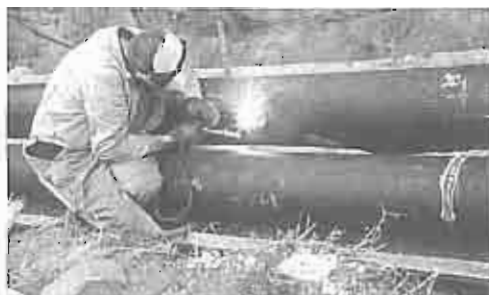
Ledningsarbejde på Ege Allé
